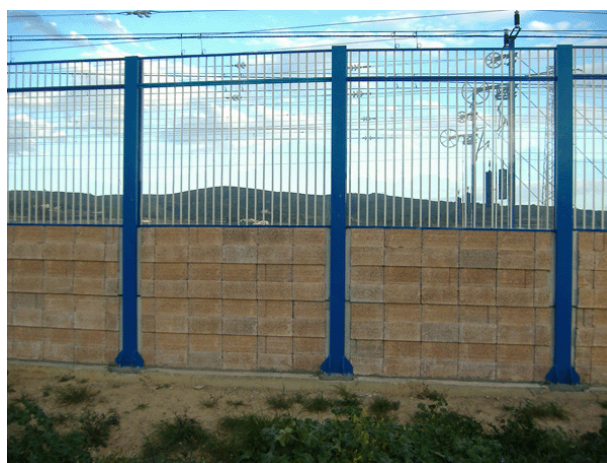
Pantalla mixta Hormigón-Metacrilato instalada en línea AVE (Barcelona)
